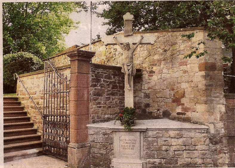
Das Kreuz am südlichen Eingang der katholischen Pfarrkirche ist dank des Baufördervereins wieder in einem tadellosen Zustand.
