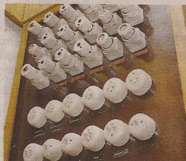
Der alte Sicherungskasten kommt weg.
