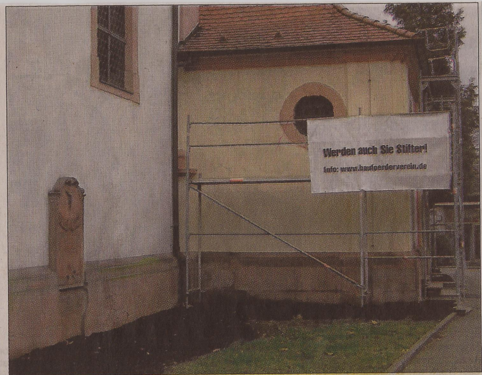
Der Bauförderverein sucht weitere Stifter, die für die Außensanierung der Hemsbacher Pfarrkirche spenden. Die Arbeiten sollen in Kürze beginnen.
